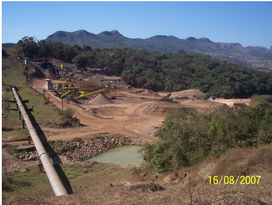
VISÃO GERAL DA PLANTA EM FASE FINAL DE MONTAGEM. 1 – PLANTA DE PENEIRAMENTO 2 – PLANTA DE CONCENTRAÇÃO
