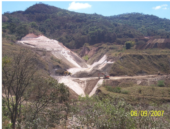
TRABALHOS DE PREENCHIMENTO DO FUNDO DA VOÇOROCA
