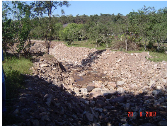
TRECHO DO CÓRREGO ESPERANÇA EM FASE FINAL DE ACABAMENTO
