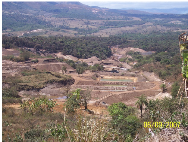
BACIAS DE RETENÇÃO ESCAVADAS NA BACIA DA BARRAGEM DE GABIÃO
