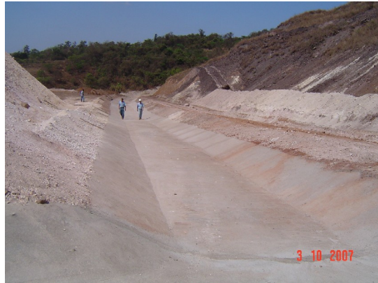
REVESTIMENTO DA CANALETA DE DRENAGEM
