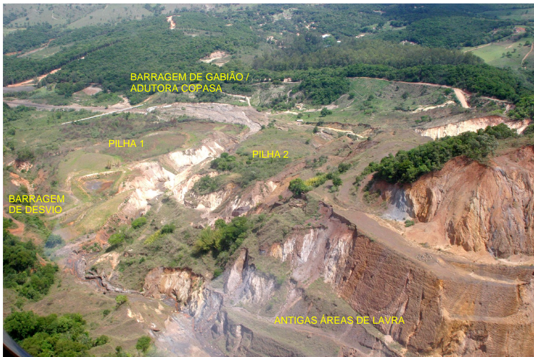
VISÃO GERAL DA VOÇOROCA A SER CORRIGIDA
